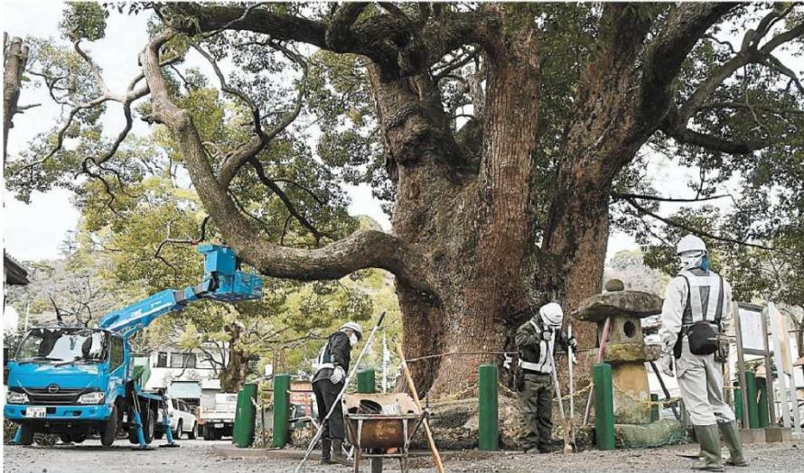
巨大なクスノキの周辺で行われる土壌改良の工事＝静岡市葵区の若宮八幡宮
