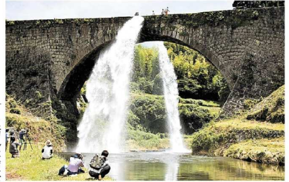
4年ぶりに放水を再開した石造りアーチ式水路橋「通潤橋」 ＝21日午前、熊本県山都町
