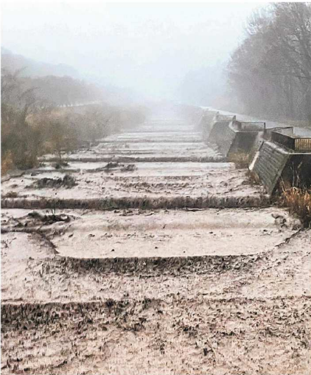
スラッシュ雪崩の影響があったとみられる大沢川扇状地付近で流れ下る濁流＝21日午後5時半ごろ、富士宮市上井出
