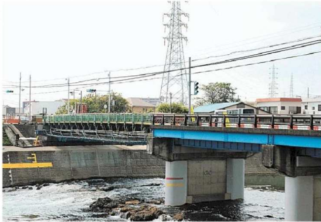
応急組立橋が架かった沼津と清水町境の黄瀬川大橋
