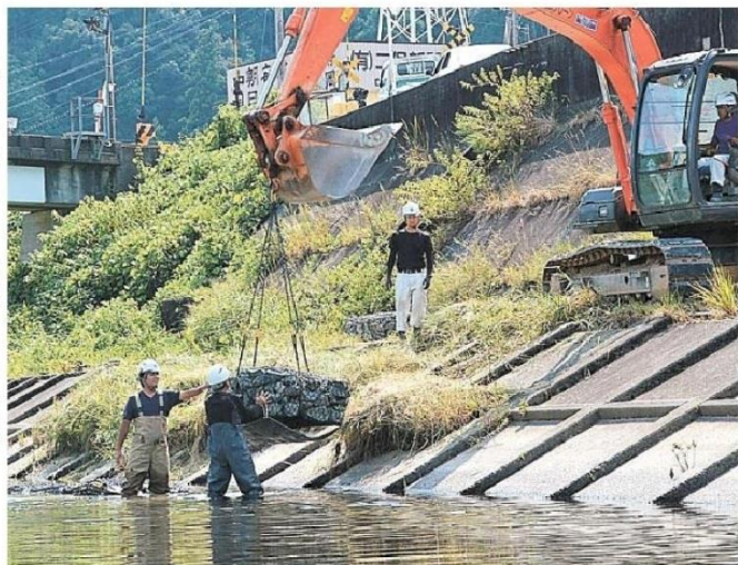
ウナギのすみかとして設置された石倉かご
