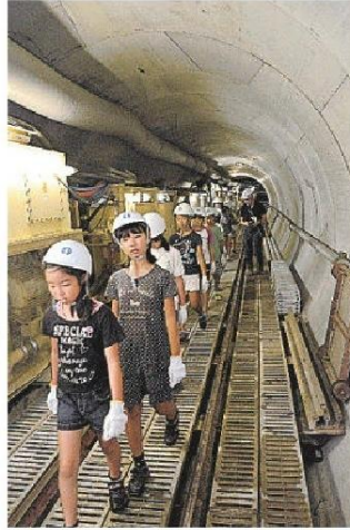
工事中のトンネル内を見学する児童―静岡市駿河区
